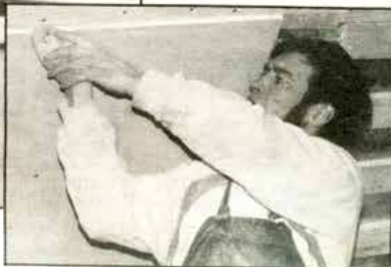
Alpo Ruonakankaan tehtävänä on kiinnittää levyt kupolin kaare- vaan pintaan.
